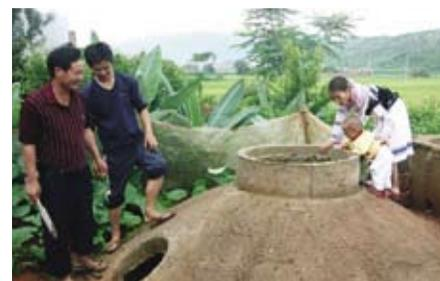
Este biodigestor permite generar gas metano a partir de los excrementos de animales.
